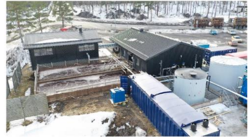
13. Jäteveden puhdistamo (oikeanpuoleinen rakennus)
