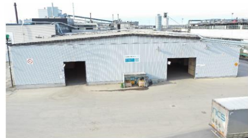
Uuden osan julkisivu kaakkoispää. Vanha rakenne hävinnyt uuden alle (3-16)
