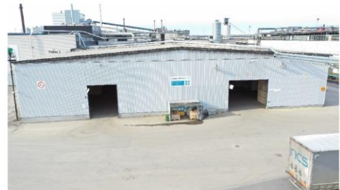
Uuden osan julkisivu kaakkoispäätä. Vanha rakenne hävinnyt uuden alle (3-16)
