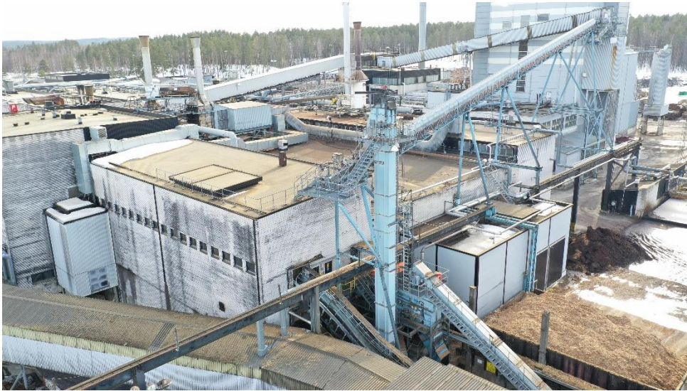
Kuva 11. Pellos 2 ja näkymä prosessilaitteiston rakennelmien kytkeytymisestä rakennukseen osana modernisaatiota.
