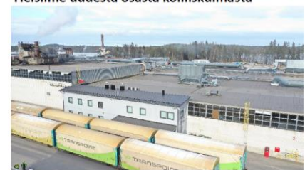
Uuden ja vanhan osan liittymä lounaispuolella
