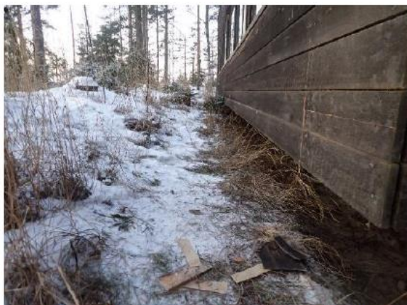
Kuva 1. Rakennuksen länsisivua. Vierustalla on kasvillisuutta, joka ulottuu paikoin ulkoseinään. Maanpinta viettää lievästi rakennusta kohti.
