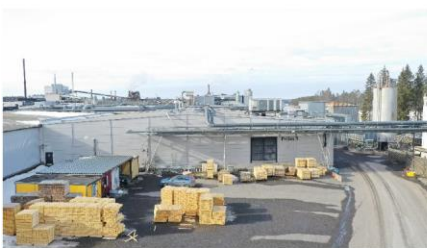
Uuden ja vanhan osan liittymä kaakkoispuolella
