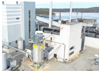
5. Vanha voimalaitos (matala osa) kytkettynä uuteen voimalaitokseen
