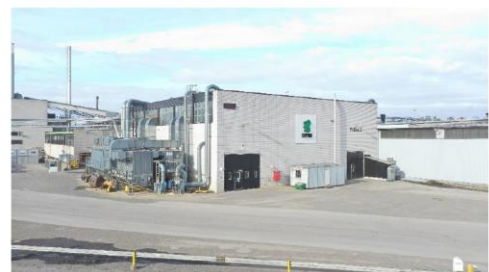
Vanhan ja uuden osan kytkeytyminen (1-16) länsipuoli. Vanhan osan kyljessä näkyy uudistettuja prosessiin liittyviä teknisiä laitteita
