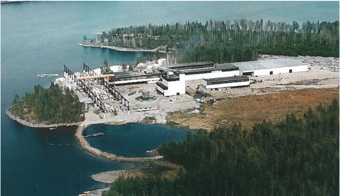
Kuva 8. Tehdasalue aloitusvaiheessa, kaikki ensimmäisen rakennusvaiheen rakennukset eivät ole vielä valmistuneet. Kuvanottoaika ei tiedossa (Lähde: UPM)
